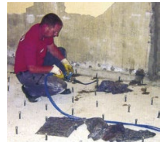
Trabajo de inyección
