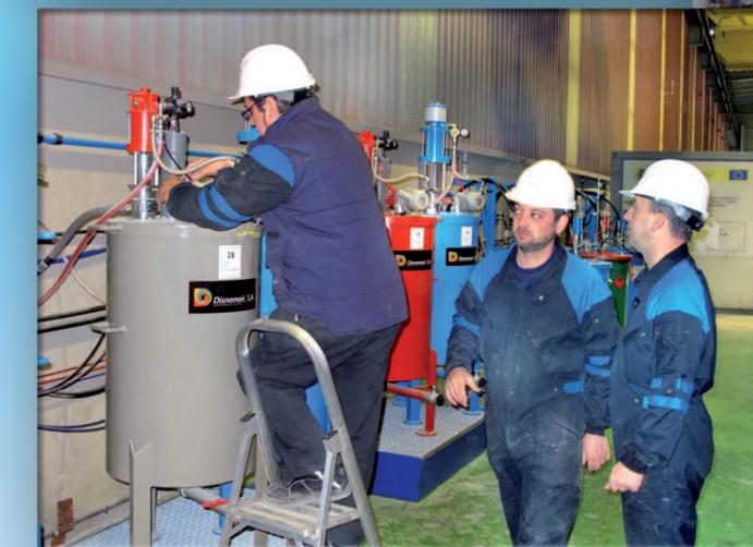
En conjunto, el rack de tuberías del sistema por las que circulan a alta presión todos los componentes incluyendo las distintas mezclas de productos hasta alimentar las pistolas de proyección, representan más de 1 kilómetro de extensión. En la fotografía superior podemos observar la zona de la instalación de llegada y retorno de los diferentes componentes y disolventes.
